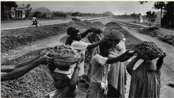
Arbeiter entlang der Bahnlinie: Infrastruktur und menschliche Bewegung greifen ineinander.
